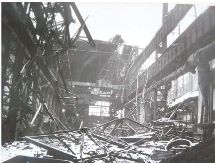
Рис. 5. Лавинообразное обрушение двух пролётов покрытия цеха литейно-арматурного завода
