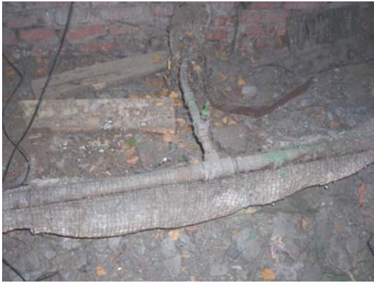
Рис. 1. Состояние изоляции труб системы отопления (разводка)
