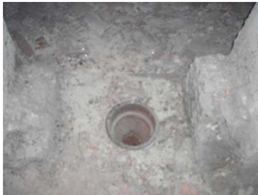
Рис. 4. Вентиляционное отверстие канализационного стояка, выходящее на чердак
